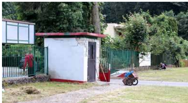
Na początek prace przy ogrodzeniu
