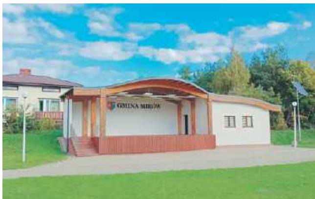
Budynek sceniczny przed remontem
