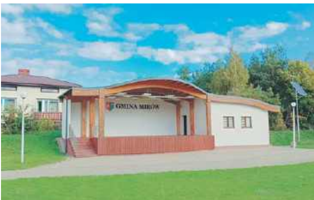
Budynek sceniczny przed remontem
