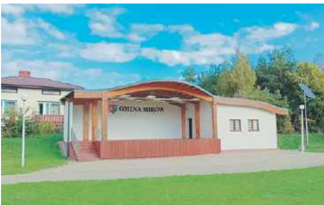
Budynek sceniczny przed remontem
