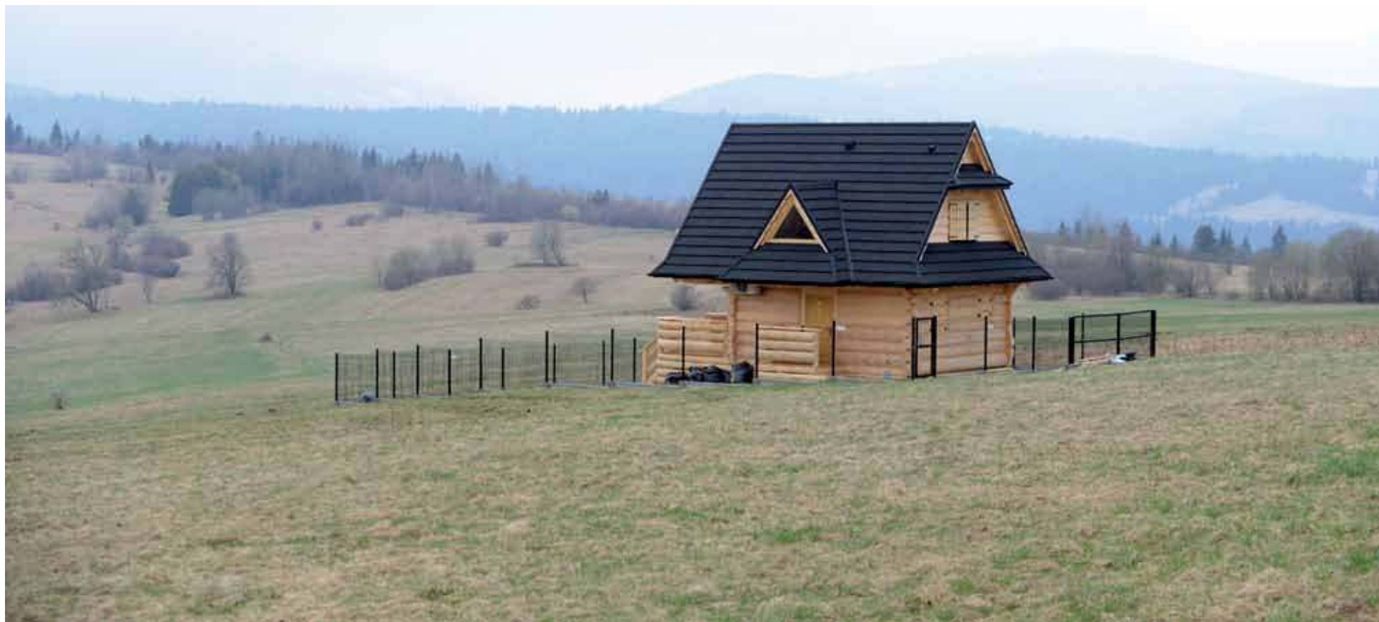
Krowiarki. Samowola budowlana.
