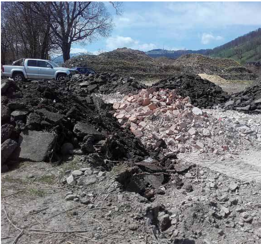
Mieszkańcy Poronina dość mają życia na gruzowisku, niestety nieprędko doczekają się uporządkowania terenu i budowy nowej drogi.
