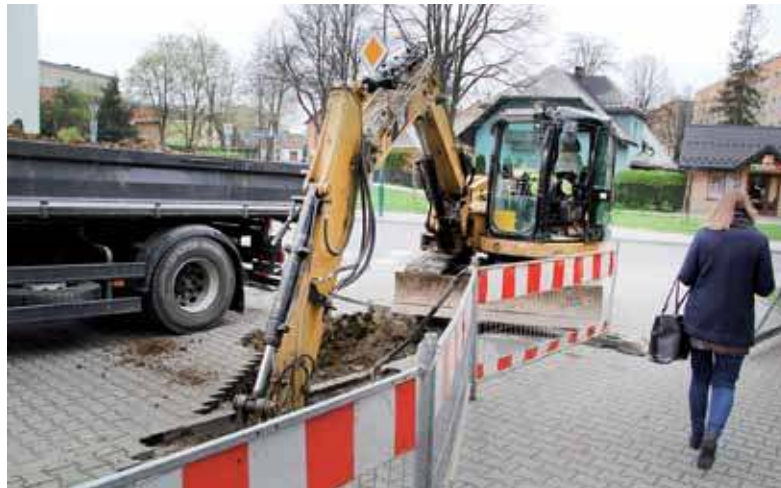
Prace przy układaniu rur ciepłowniczych w ul. Na Równi już się rozpoczęły.
