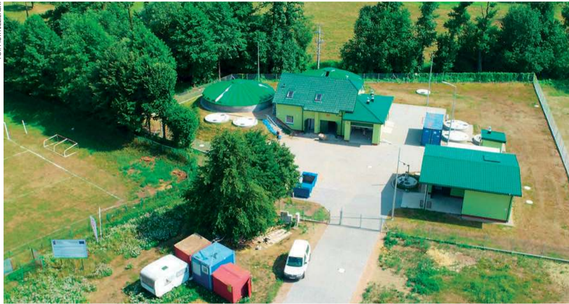
Oczyszczalnia ścieków w Nowym Mieście
