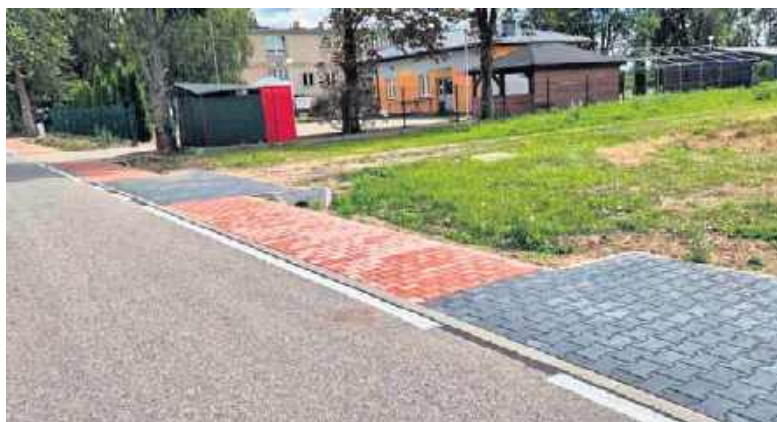
Niedawno została zakończona budowa chodnika w Dębinach, biegnącego przy świetlicy wiejskiej. W Dębinach trwa też budowa boiska.
