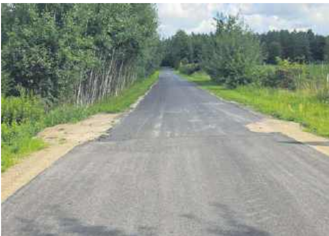
Odcinek drogi DK48-Witaszyn do remontu
