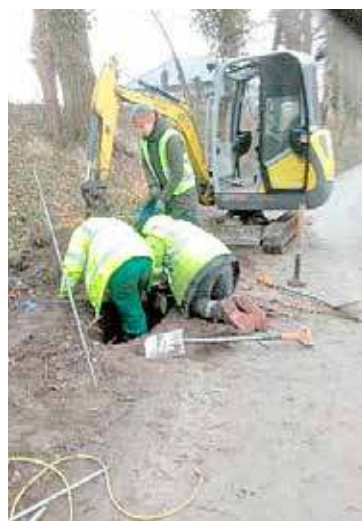
Trwa montaż masztów oświetleniowych wzdłuż ścieżki
