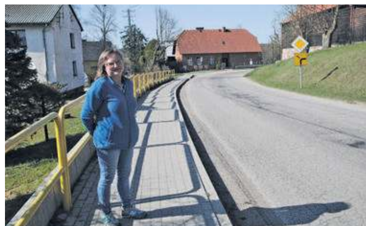
Sołtyska Alicja Borzyszkowska mówi, że droga jest w naprawdę kiepskim stanie. Asfalt w wielu miejscach jest spękany.
