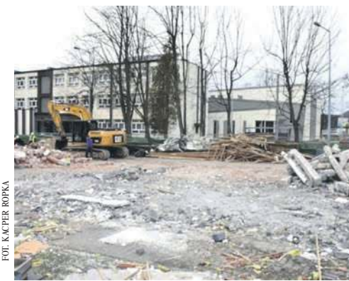
Wyburzanie placu targowego w lutym 2020 r.
