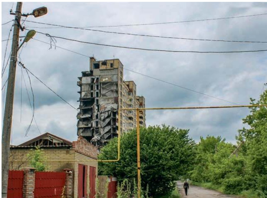
W centrum miasta każdy budynek jest uszkodzony, Awdijiwka, maj 2023 r.
