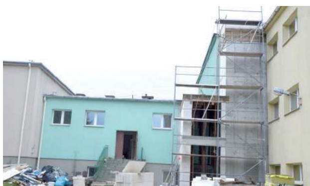
Winda zlokalizowana będzie z tyłu budynku. Wykonana została już większość konstrukcji żelbetowej szybu windowego
