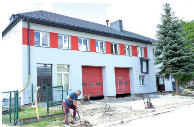
Z dachu remizy w Wólce Polanowskiej zniknął eternit, który już przeciekał. Dach został docieplony. A cały budynek zyskał nową elewację
