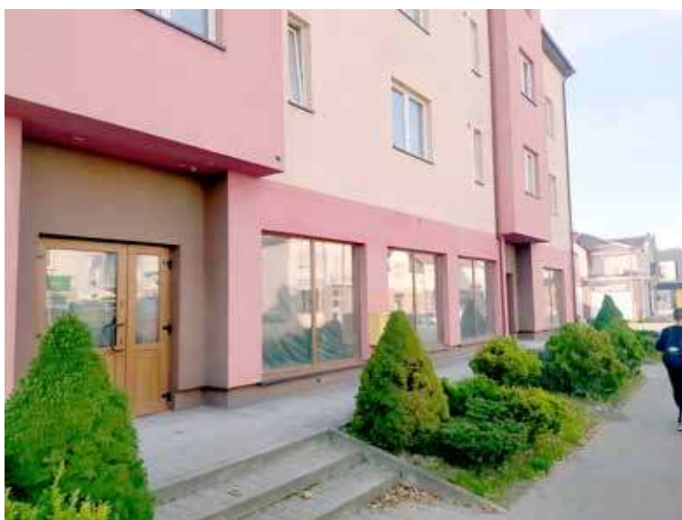
Od pewnego czasu przy ul. 700 Lecia 11 trwają prace adaptacyjne pod nową siedzibę oddziału Banku PKO BP
