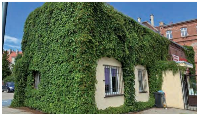
Program dla Osobłogi promuje rozwiązania redukujące odpływ wody w obszarach zurbanizowanych, na przykład tzw. zielone fasady. Na fotografii budynek redakcji Tygodnika Prudnickiego.
