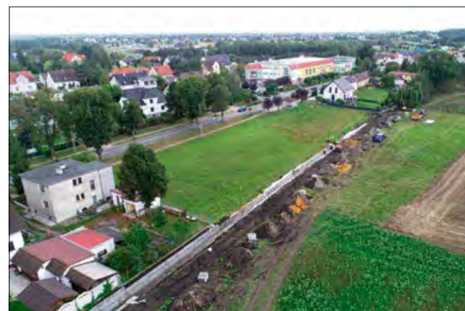
Tak postępują prace w Gogolinie-Karłubcu.
