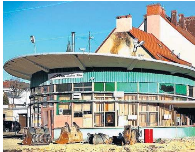
Likwidacja dworca PKS w Sulechowie. Nowy ma powstać naprzeciwko stacji PKP. Miasto przejęło teren od kolei i w ramach Lubuskiego Trójmiasta stara się pozyskać pieniądze na budowę Centrum Przesiadkowego
