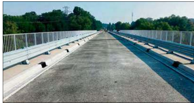
Na moście brakuje jeszcze tylko drugiej warstwy asfaltu i latarni.
