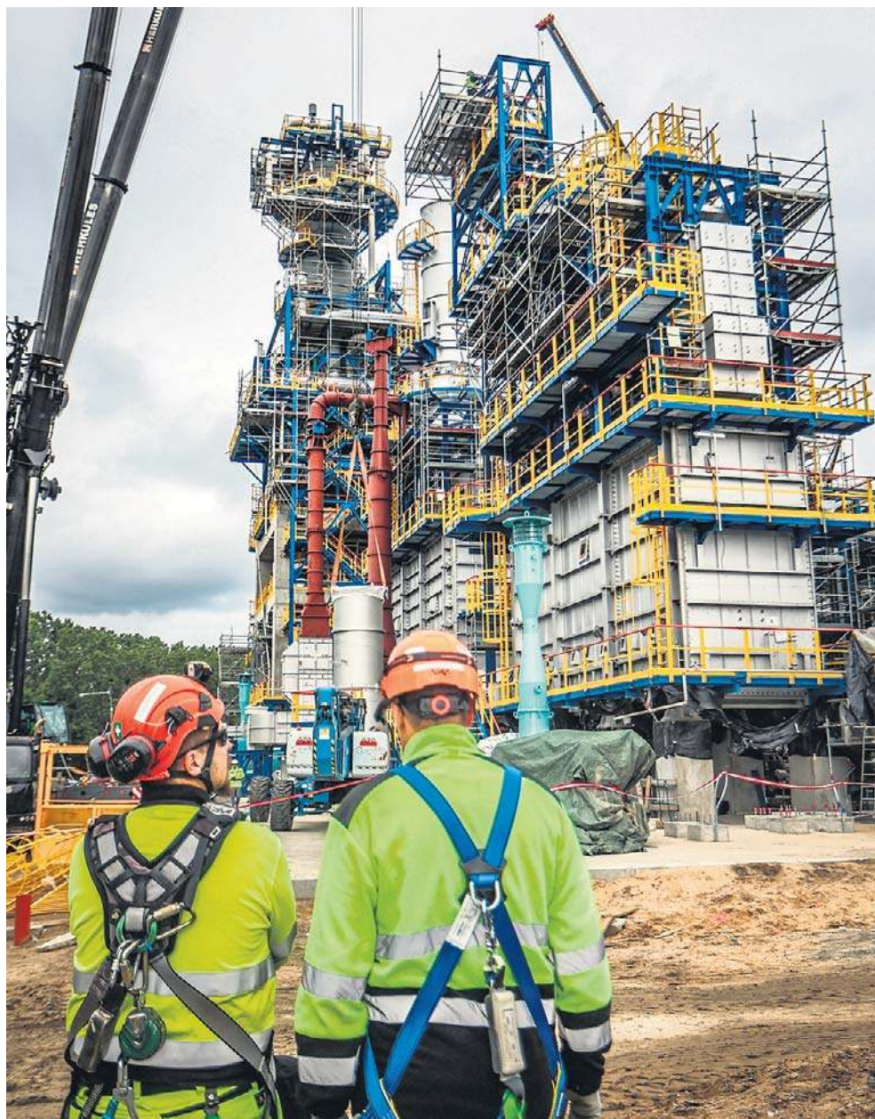
Montaż kominów odprowadzania spalin dwóch pieców technologicznych instalacji HBO. Każdy z segmentów kominów waży od 4 do 17 ton
