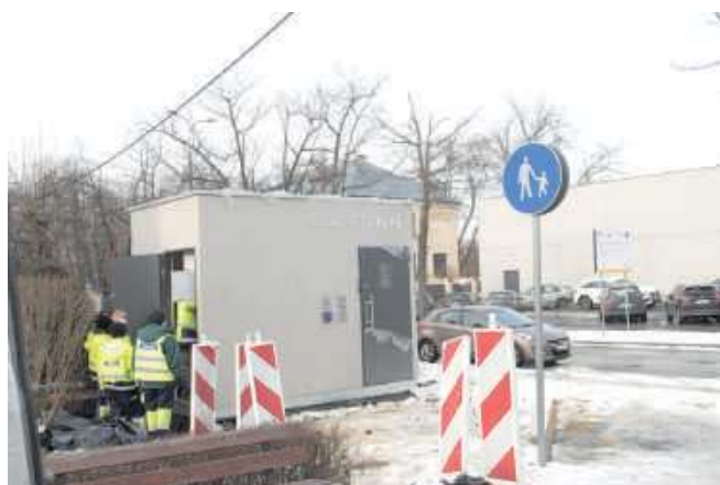
Toaletę zamontowano w ub. piątek. Jeszcze nie wiadomo, ile będzie kosztowało skorzystanie z niej, ale ceny mają być „atrakcyjne”
