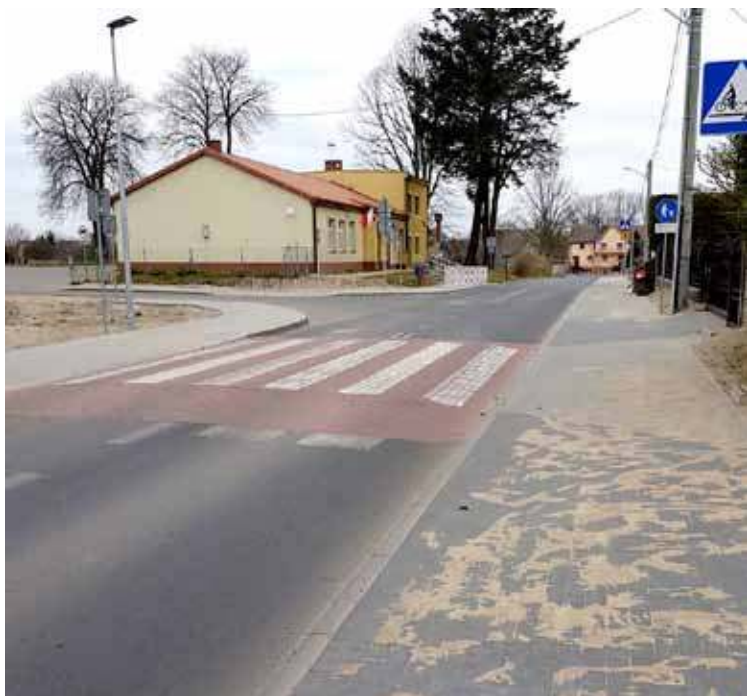
W Grzędzicach przebudowano 2,92 km drogi. Wybudowano również ścieżkę rowerową
