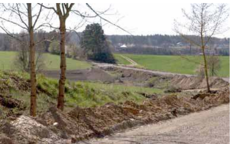
Ekipy budowlane usunęły drzewa i krzewy, które kolidowały z przebiegiem budowanej drogi
