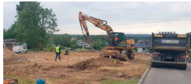
Z budowanego parkingu skorzystają w przyszłości m.in. klienci krytej pływalni
