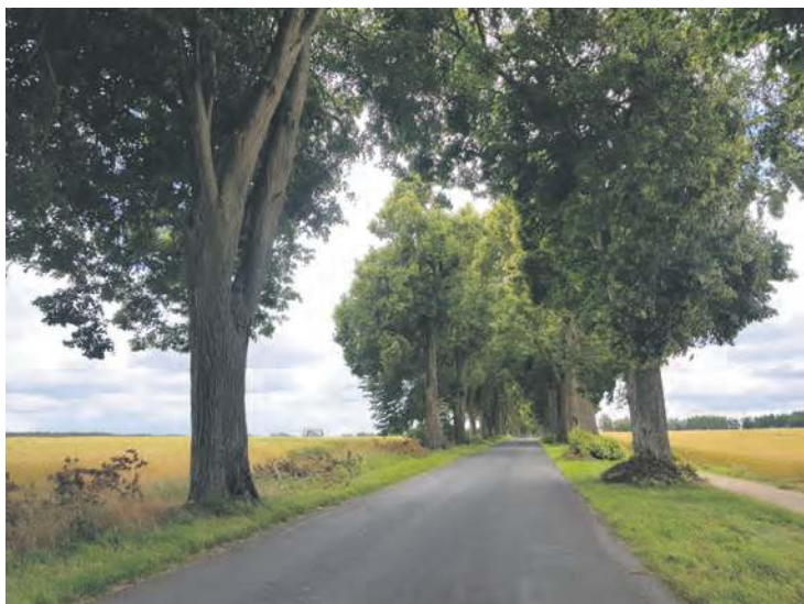
Ta droga doczeka się remontu.
