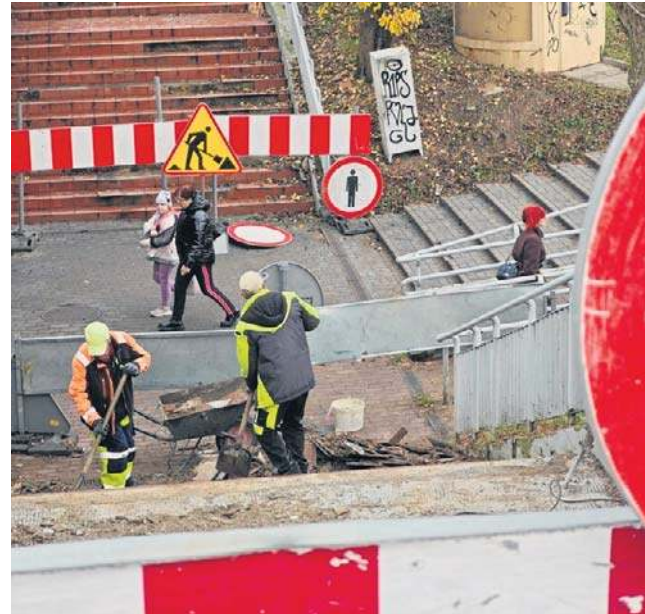
Rozpoczął się remont dwóch schodów prowadzących do przejścia podziemnego przy placu Skarbka
