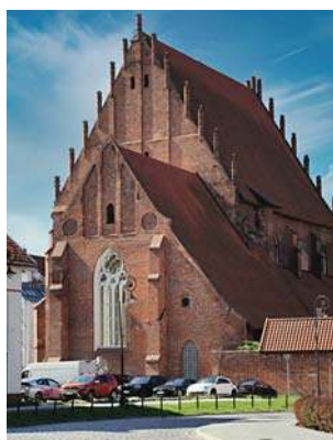
Galeria EL. Przetarg obejmuje prace przy murach budynku oraz wewnątrz obiektu
