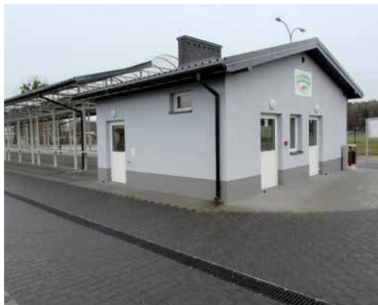
Gmina Ojrzeń - Wspieranie lokalnego rozwoju Gminy Ojrzeń poprzez rozbudowę dróg: Kraszewo - Skarżyniek - Łębki Wielkie; w miejscowości Bronisławie i przebudowę ul. Przedszkolnej w miejscowości Ojrzeń
