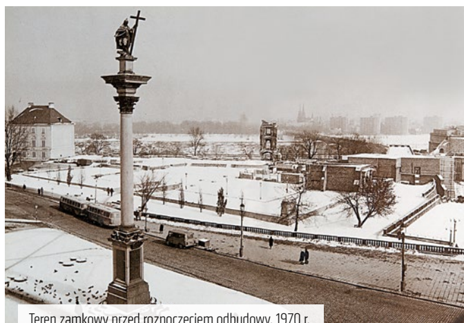
Teren zamkowy przed rozpoczęciem odbudowy, 1970 r.
