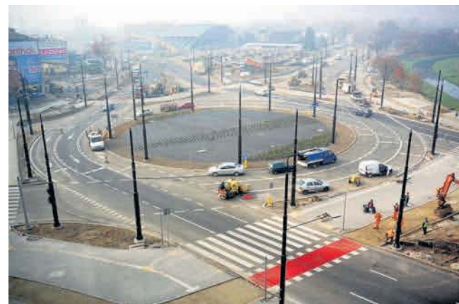
Przebudowa ronda przy Gali kosztuje 61 mln. Inwestycja obejmowała też m.in. przebudowę mostu na Czerniejówce
