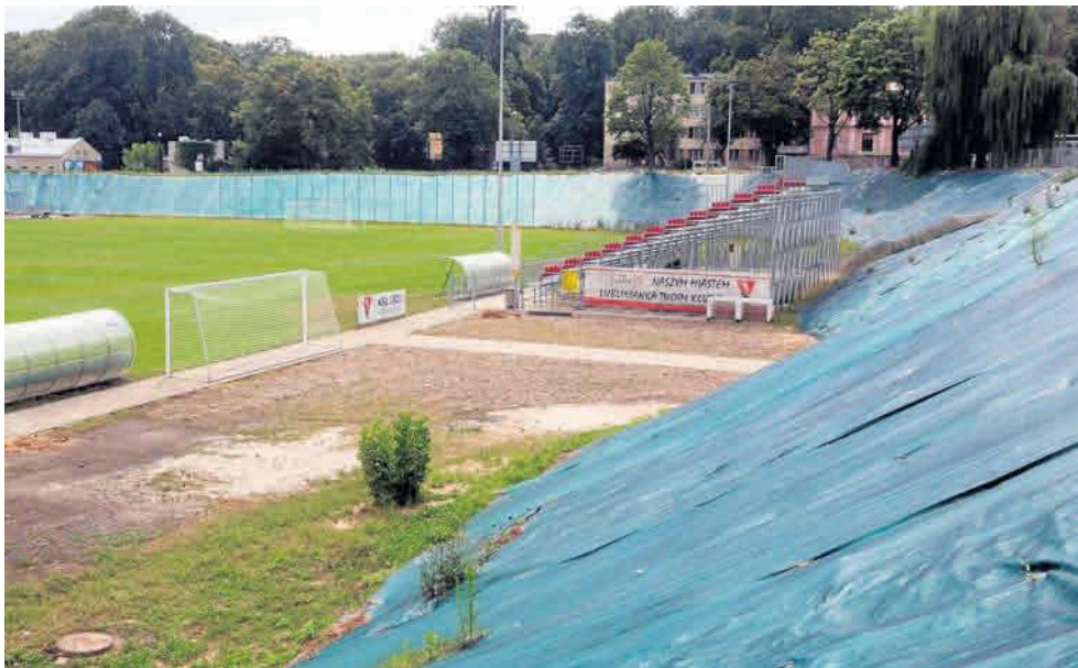
Przebudowa stadionu Lublinianki przy ul. Leszczyńskiego pochłonęła do tej pory 4,3 mln zł
