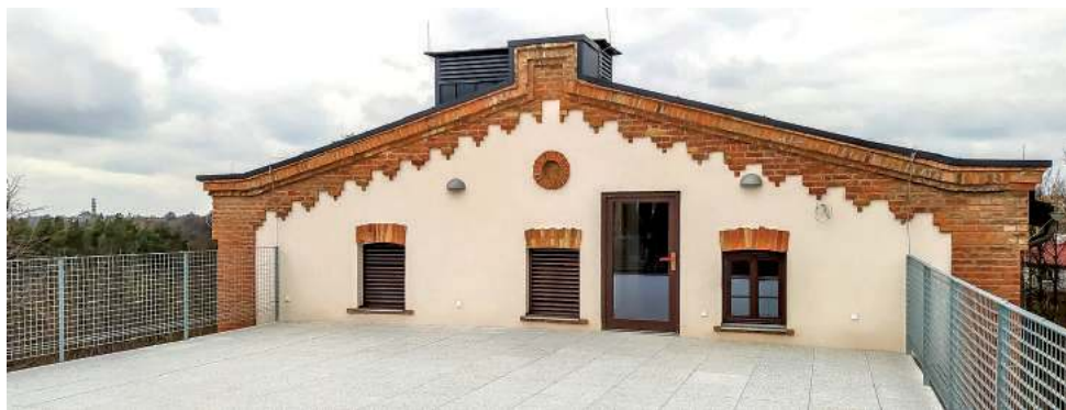
Na poddaszu wybudowano hol rekreacyjny połączony z wyjściem na taras widokowy
