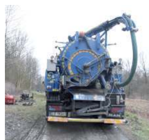
Na miejscu pracowały dwa specjalistyczne pojazdy WUKO do udrażniania kanalizacji
