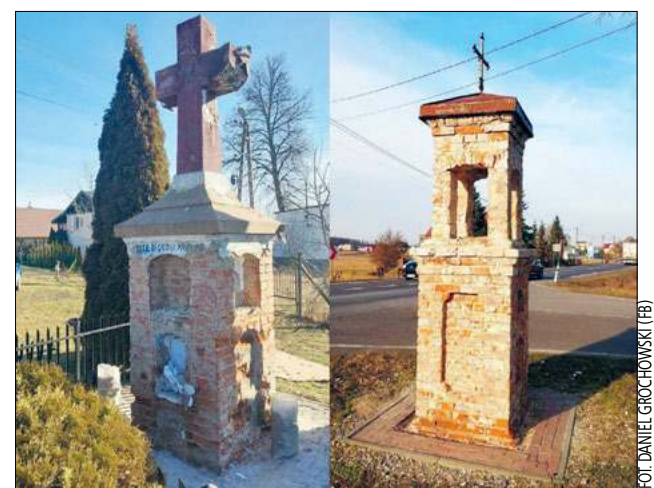
W gminie Radzyna Podlaski rusza renowacja kapliczek przydrożnych
