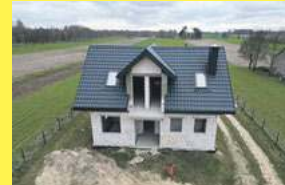
Dom w stanie surowym otwartym, Wólka Siemieńska, 885 851 160
