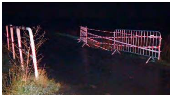
Na ten moment miejsce brakującej barierki jest zabezpieczone taśmami.
