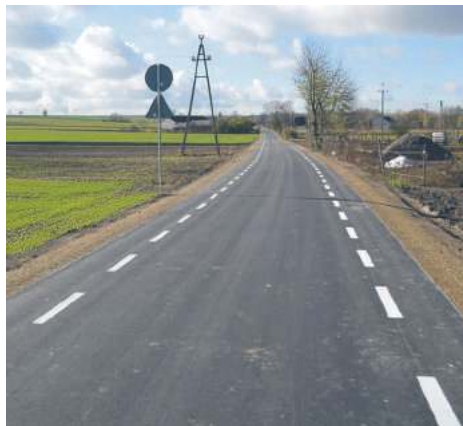
Przebudowa 23 odcinków dróg o długości ponad 21 km
