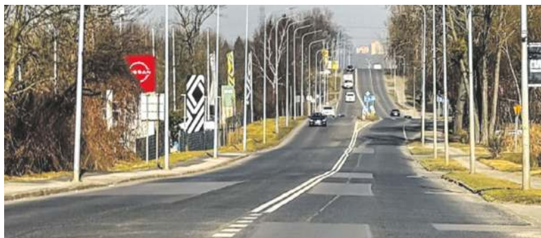
Naprawa uszkodzonej jezdni ucieszy kierowców
