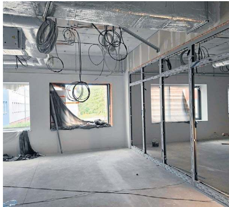
W powstającym pawilonie włocławskiej lecznicy zaplanowano aż siedem nowoczesnych sal operacyjnych
