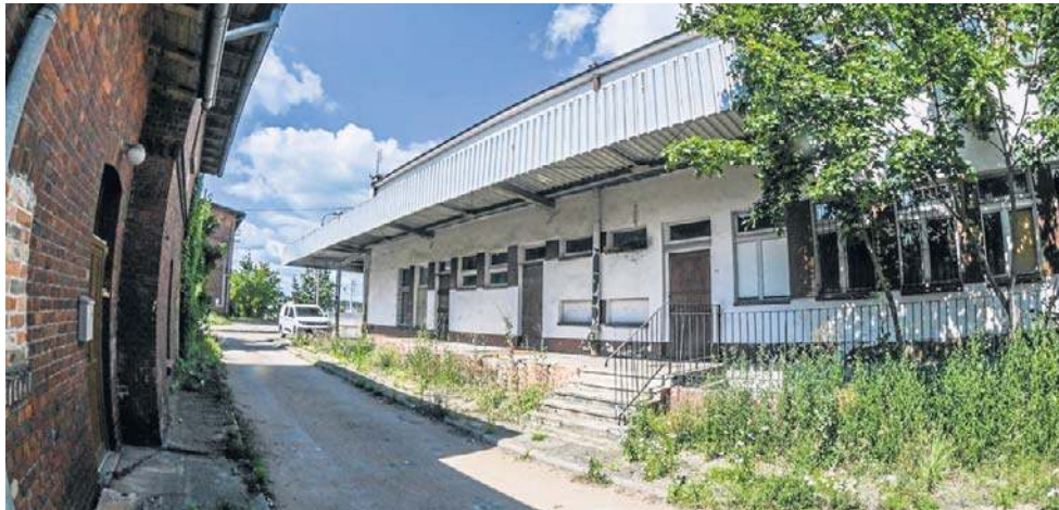
Odrapany, zaniedbany budynek znajduje się tuż obok nowej stacji kolejowej w Fordonie
