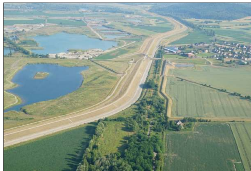
Zdjęcie wału przeciwpowodziowego w gminie Lubomia
