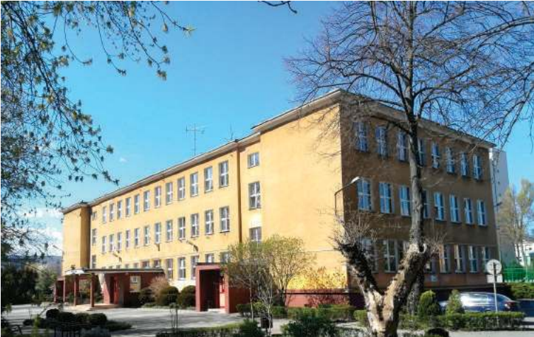
SP nr 6 przejdzie kompleksową termomodernizację
