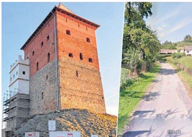
Droga prowadząca na wzgórze zamkowe jest obecnie bardzo wąska. Po remoncie się to zmieni
