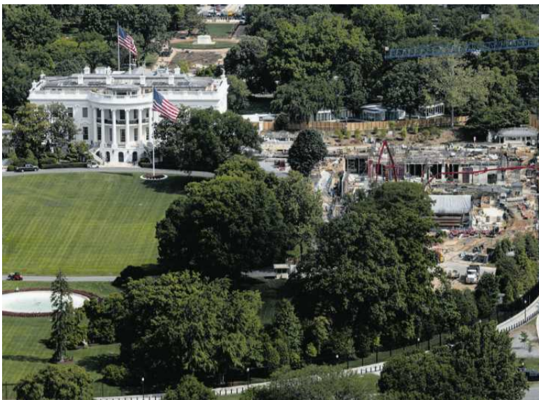
• Trwają prace budowlane nad planowaną salą balową Białego Domu w rejonie dawnego skrzydła wschodniego. FOT. REUTERS / EVELYN HOCKSTEIN
