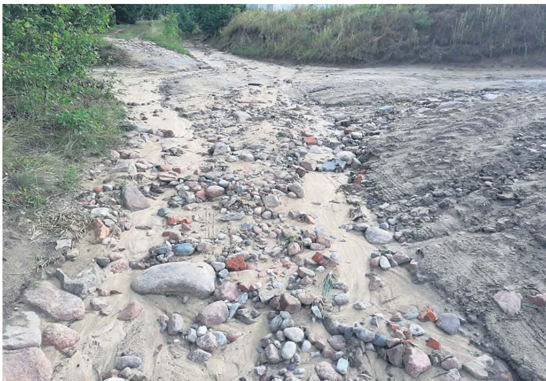
Droga w Teologu, która dotychczas była gruntowa, zostanie przebudowana i pokryta asfaltem. Fot. nadesłane
