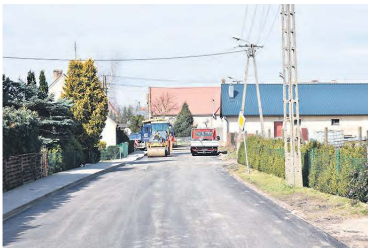
Remont w Bystawiu obejmuje ulice Spokojną i Szkolną... Fot.(kt)
