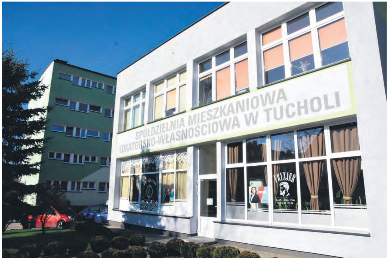
Spółdzielnia Mieszkaniowa Lokatorsko-Własnościowa w Tucholi planuje na bieżące remonty wydać łącznie 1,7 mln zł.
