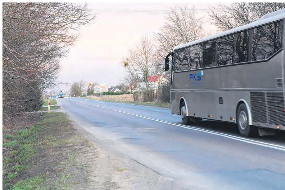
W kierunku Bładowa zostanie położona nowa nawierzchnia. Na razie na odcinku 990 metrów.
