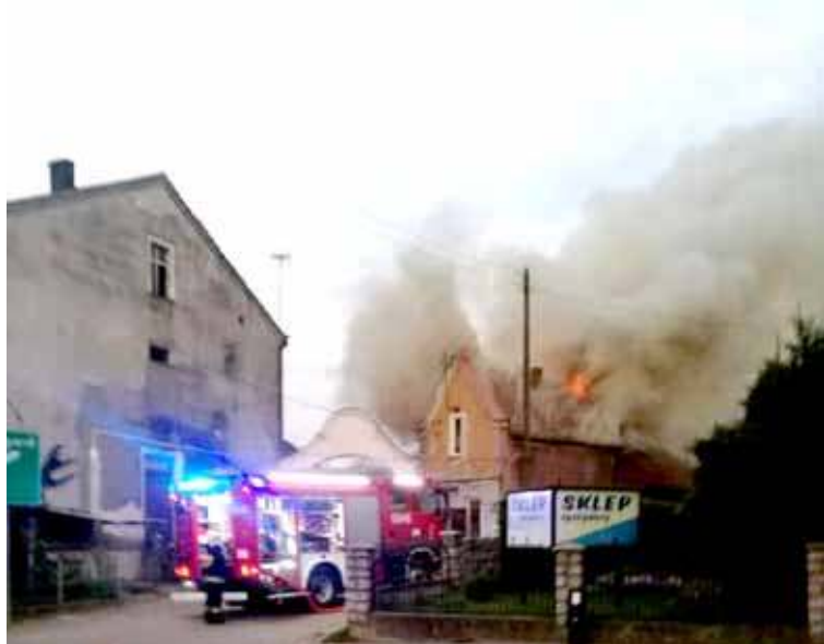
24 kwietnia w Chociwlu spłonęło poddasze oraz dach w budynku mieszkalnym
