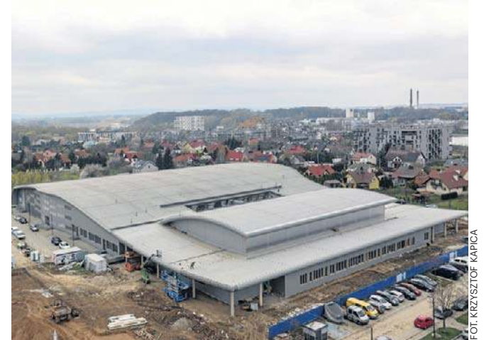
Budowa jest na etapie robót instalacyjnych i wykończeniowych
