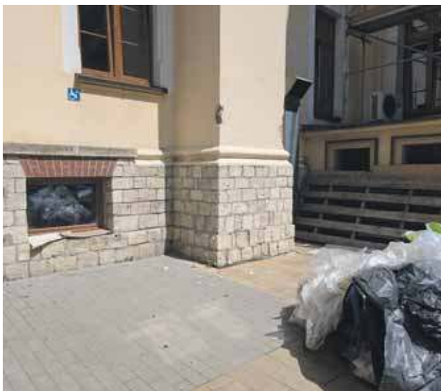
Miejsce dla niepełnosprawnych jest zastawione
