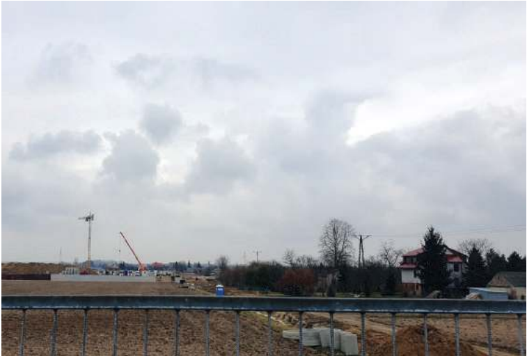
Położony kilka miesięcy temu kosztem 550 tys. zł dojazd z płyt do placu budowy bloków „Mieszkanie Plus” zostanie rozebrany, bo w ich miejscu powstaje asfaltowa ulica
