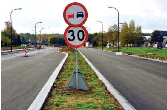
Nowo budowana ulica Kusocińskiego i jej stary, nieprzewidywany do remontu odcinek na wysokości stacji paliw Orlenu
