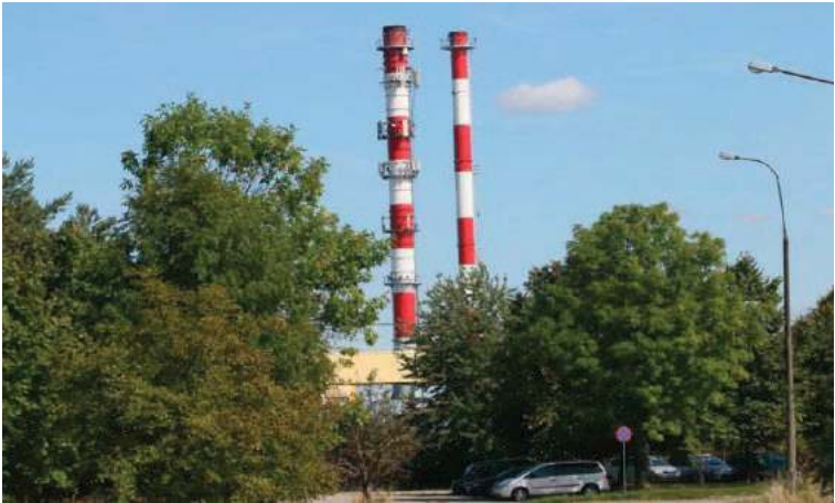
Budową instalacji do spalania biomasy i odpadów jest zainteresowana świdnicka elektrociepłownia Veolia
