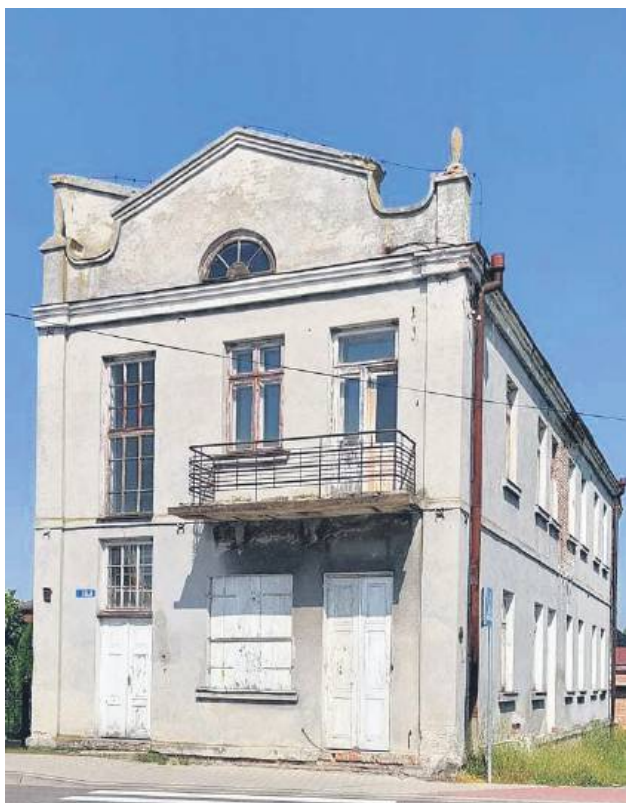
Budynek znajduje się w centrum Tyszowiec.
