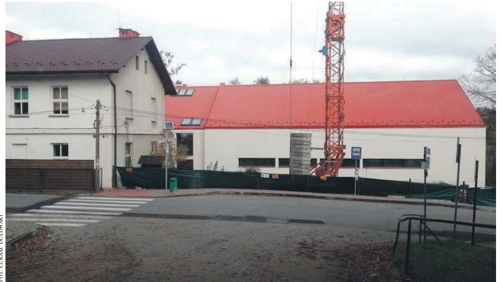
Trwa rozbudowa Szkoły Podstawowej w Grojcu
