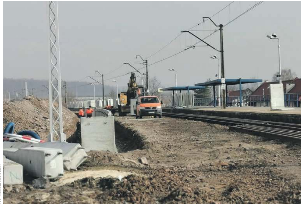
Prace w rejonie stacji kolejowej Chrzanów Śródmieście
