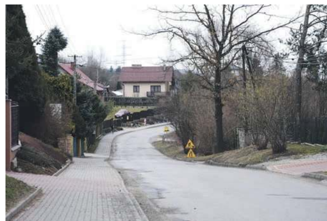
(e) Na ul. Żbickiej zacznie się budowa kanalizacji
