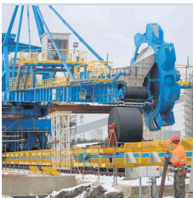
W 2018 r. średnio każdego dnia na budowie pracowało 2190 osób
