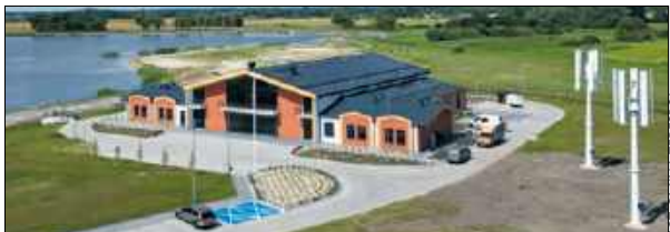
Obiekt imponuje swoimi rozmiarami — jego kubatura to 14 002,45 m sześć., a powierzchnia zabudowy wynosi 2 232,80 mkw.
