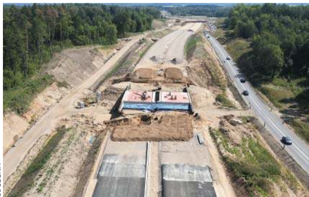
Obecnie w budowie jest odcinek S16 Borki Wielkie – Mrągowo, który ma być gotowy w pierwszym półroczu 2024 roku
