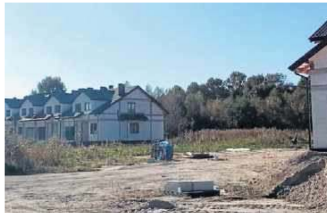
W Wólce Klwateckiej powstaje osiedle domów w zabudowie szeregowej, wątpliwości dotyczą nowych pozwoleń na budowę.
