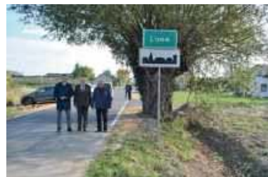
W Lisowie odbył się odbiór techniczny drogi po gruntownej przebudowie z udziałem przedstawicieli władz.
