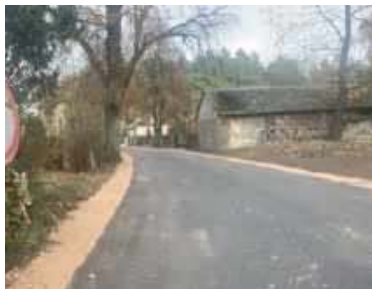
Nowym asfaltem kierowcy jeżdżą przez Okrąglik, wykonano tam też podbudowę pod jezdnię.
