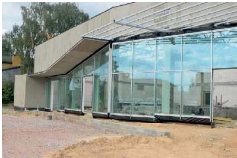
W Białobrzskim Centrum Kultury będzie między innymi sala kinowa, trwa budowa nowego skrzydła
