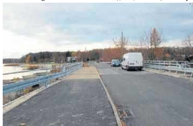
Kończy się przebudowa ulic Polnej i Spacerowej w Pionkach. Wykonawca układa jeszcze nawierzchnię na podjazdach i moście.
