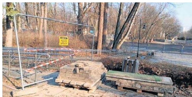
Tak wygląda obecnie przebudowywana Aleja Zakochanych
