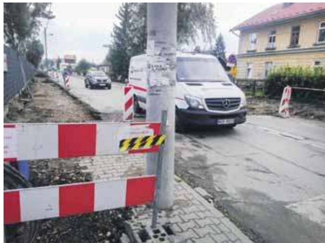
Na Kolejowej trwa remont - nowa droga poprowadzi do wyremontowanego dworca kolejowego i właśnie budowanego hotelu.
