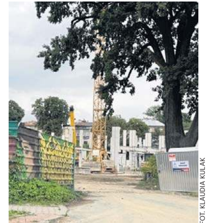
Trwa przebudowa Starego Młyna. Zmiany są już widoczne z ulicy
