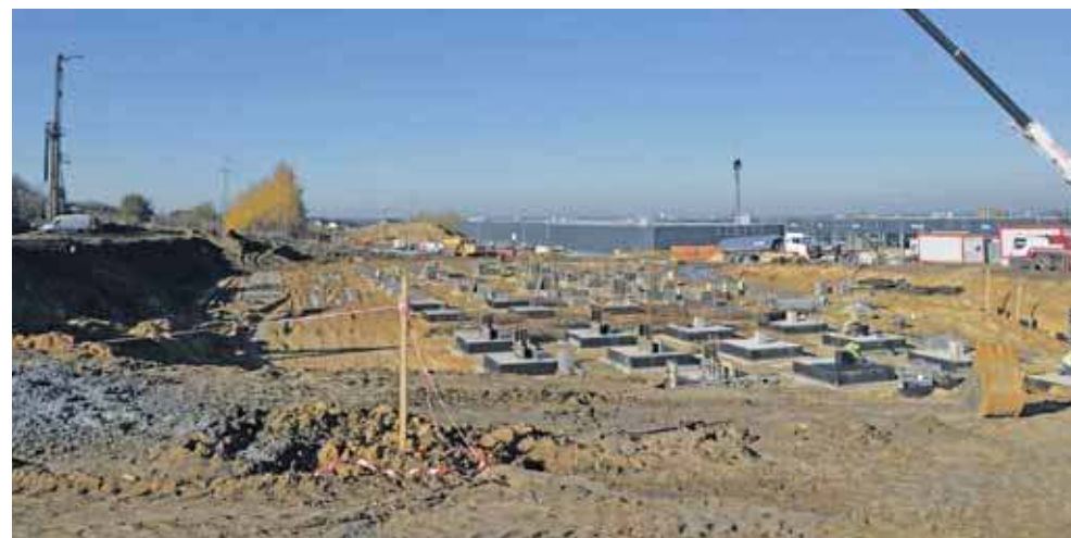
Inwestorem jest Merkur Market – sieć sklepów budowlano-ogrodniczych. Plac budowy jest w pobliżu S1 Center i KFC
